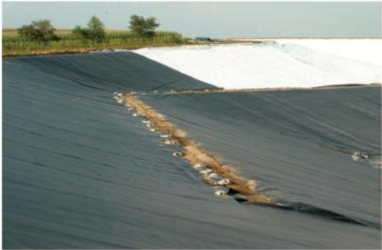
雁群垃圾填埋场边坡工程
