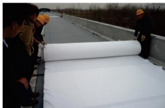
京石高铁项目施工现场
