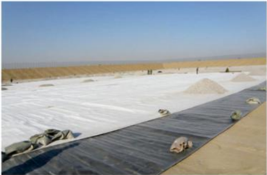
河北黄骅垃圾填埋场项目
