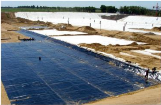
平乡垃圾填埋场项目
