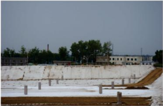
河北高碑店垃圾填埋场项目
